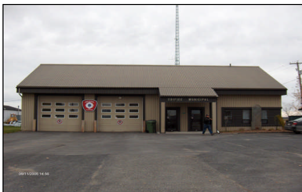
Caserne 2 de la Régie incendie du Lac-Saint-Pierre 1471, rang Saint-Pierre Saint-Zéphirin-de-Courval, J0G 1V0
