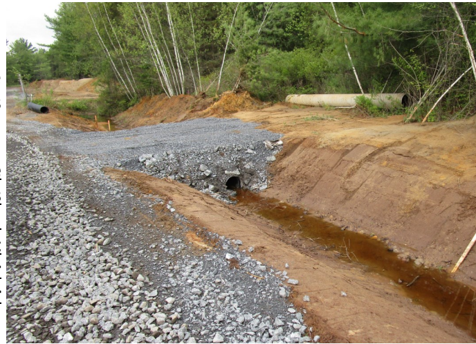
Ponceau d'entrée de terrain- rue Gabriel, Domaine du Rêve, travaux de municipalisation effectués
